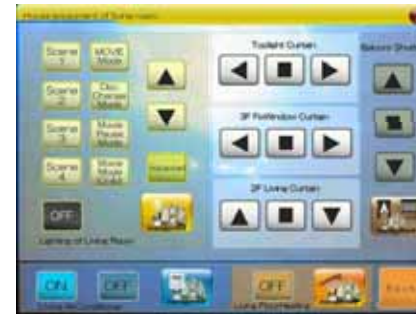
各部屋の住宅設備操作画面
